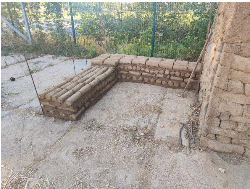
Obr. 12 – experimentálně zhotovené válkové zdivo včetně nároží (viz varianta III.)
