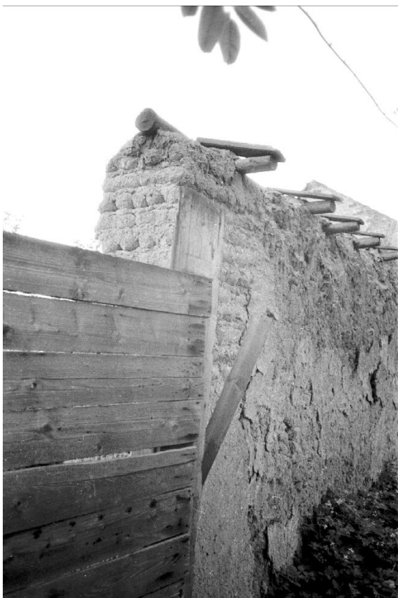
Obr. 7 – historická fotografie torza stodoly v Hrušce (okr. Prostějov) s patrným uspořádáním válků a maltových spár (foto Z. Syrová, 1989)
