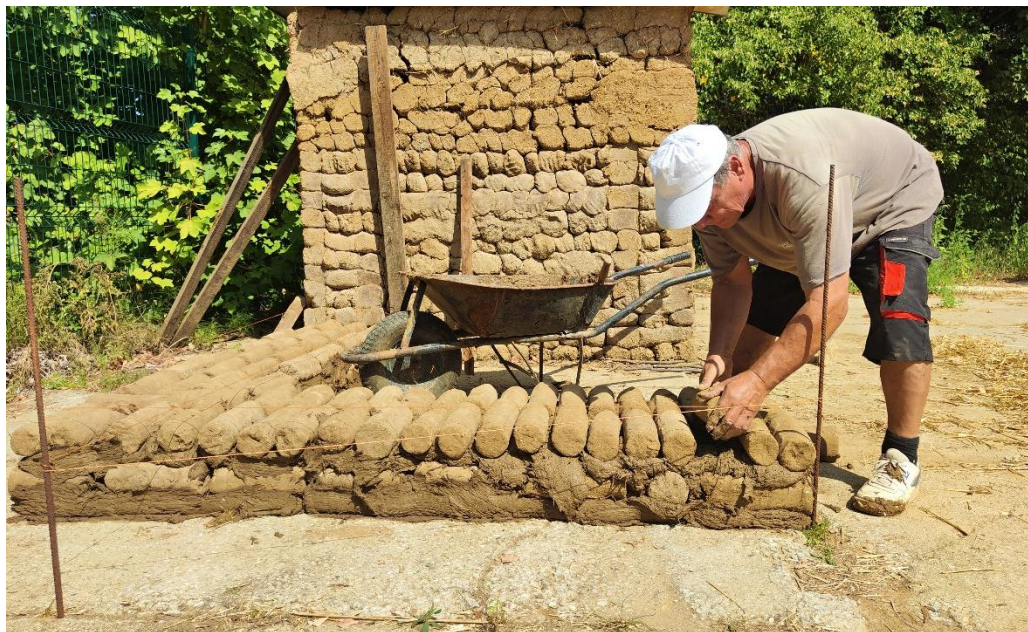
Obr. 8 – experimentální stavba válkové stěny (viz varianta III.)
