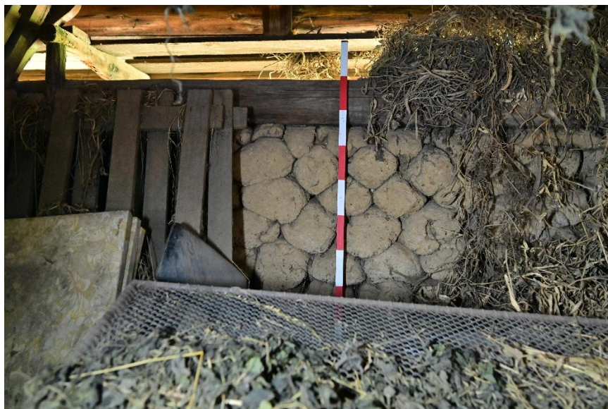
Obr. 4 – Kojetín, Mlýnská čp. 284 – pohled na válkové zdivo
