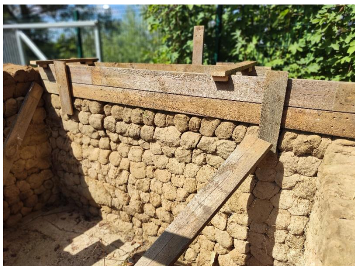
Obr. 6 – Příklad použití bočních vymezovacích prvků u experimentálně budovaného válkového zdiva (viz varianta II.)
