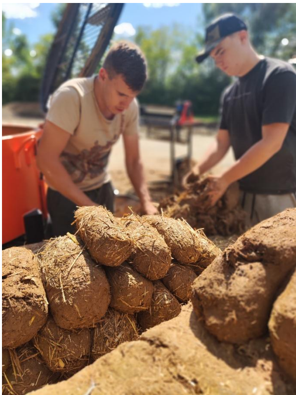
Obr. 3 – Pracovní plocha a ruční výroba válků
