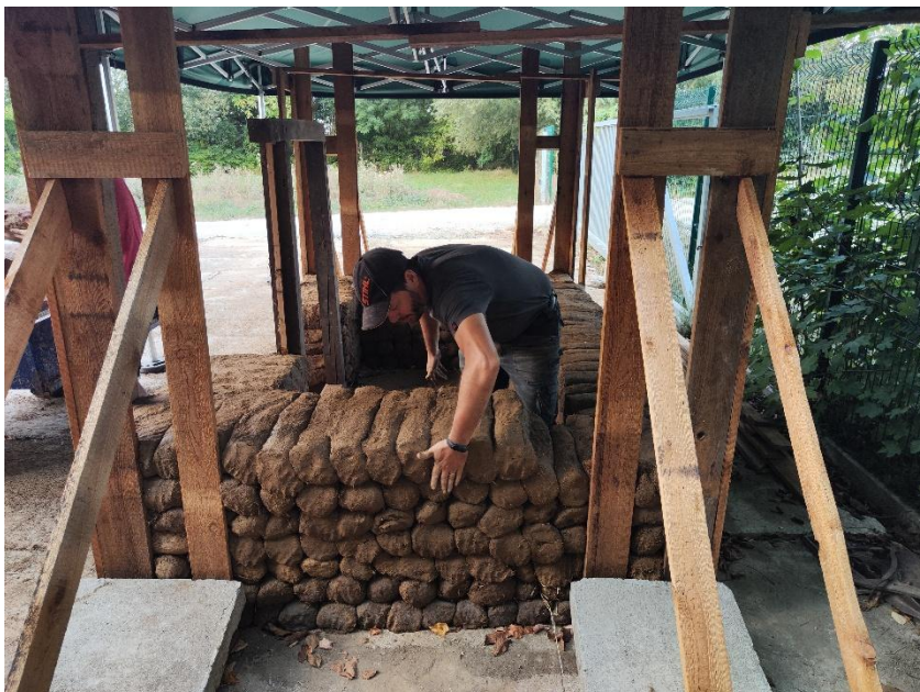
Obr. 11 – experimentální rekonstrukce vazákové vazby válkového zdiva (viz varianta I.)
