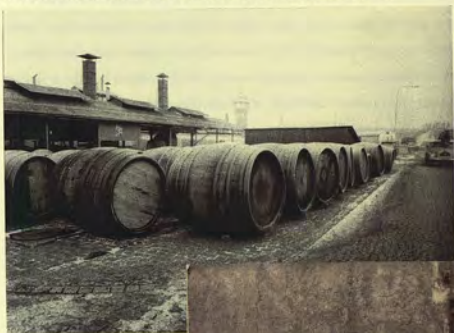
Skladování ležáckých sudů, 1974
